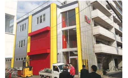
新工場は「製造業のテーマパーク」を目指して、工場らしくない明るい外観となっている。
