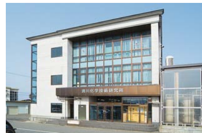
先端技術開発センター外観。技術開発まで社内で請け負うことで、顧客と自社のノウハウ流出防止にもつながる。
