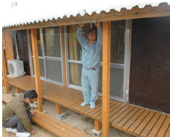
古民家のリフォームは従業員の手作業。「人口増加のきっかけになれば」と期待する
