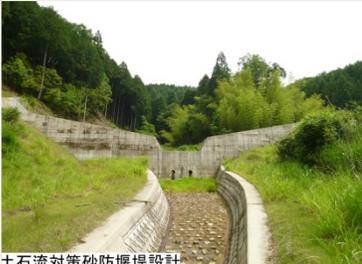
土石流対策砂防堰堤設計
